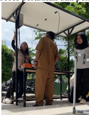
Gambar 4. Proses perakitan dan pemasangan alat (2)
