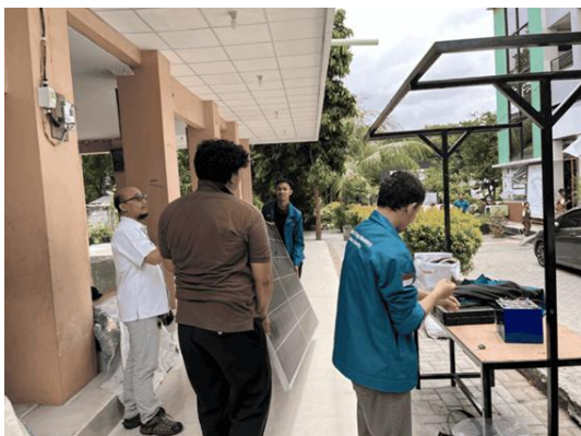
Gambar 3. Proses perakitan dan pemasangan alat
