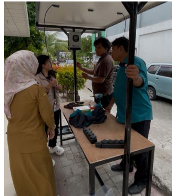
Gambar 7. Proses perakitan dan pemasangan alat (5)
